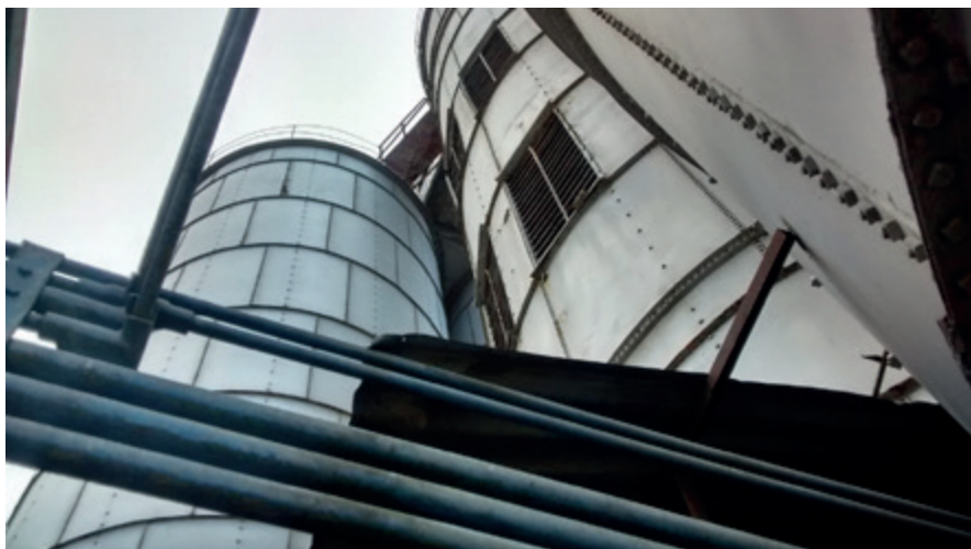
Figura 8. Silos del Idema – Detalles de la estructura Fotografía: Autor, 2015
