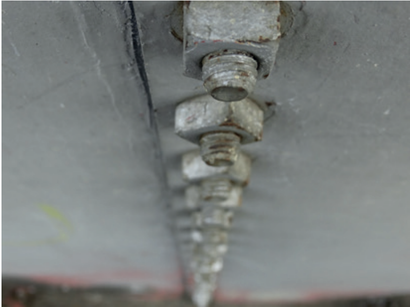
Figura 22. Silos del Idema – Detalle del ensamble de la estructura. Fotografía: autor, 2016
