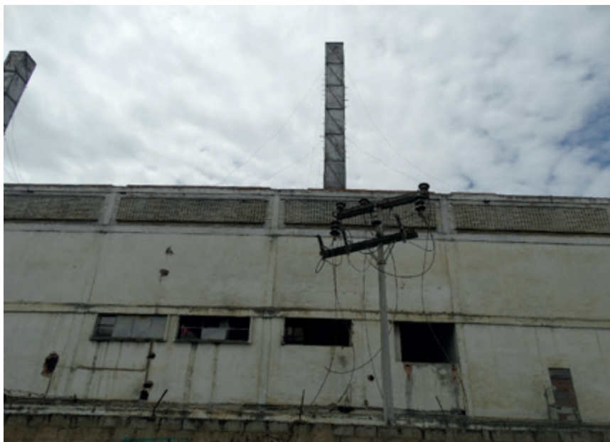
Figura 3. Ferroaleaciones. Vista desde la calle divisoria con la electrificadora. Fotografía: Autor, 2015
