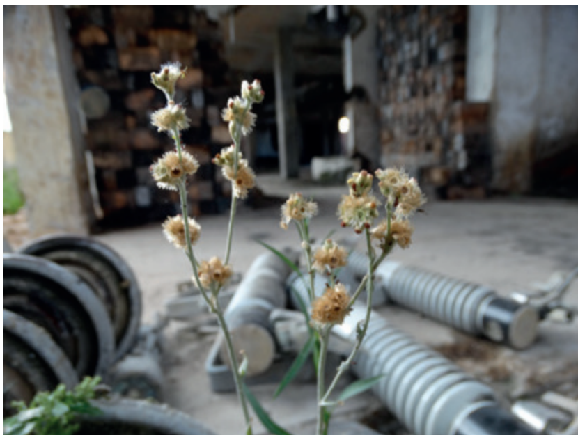
Figura 35. Ferroaleaciones – Elementos de conexión de energía. Fotografía: Autor, 2016
