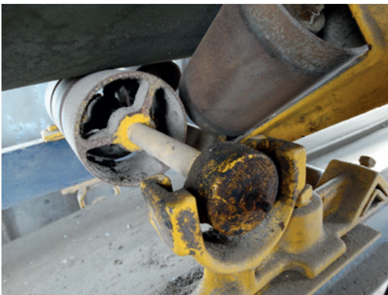
Figura 32. Silos del Idema – Máquina transportadora de granos - detalle. Fotografía: Autor, 2016
