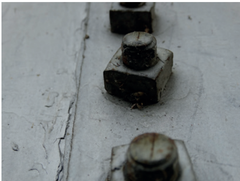
Figura 27. Silos del Idema – Detalles del ensamblaje. Fotografía: Autor, 2016
