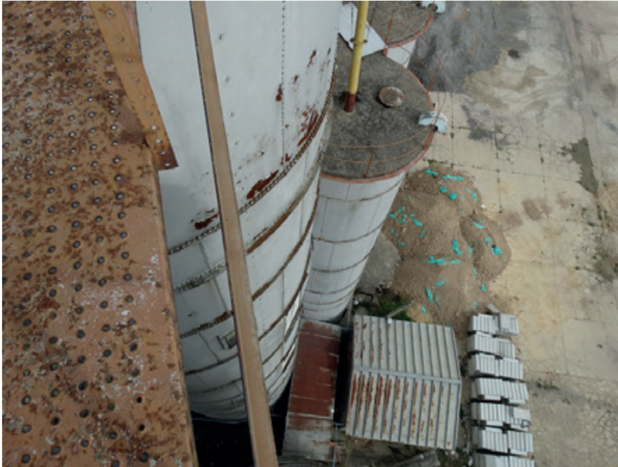
Figura 2. Silos del Idema. Vista desde la cima de la estructura. Fotografía: Autor, 2015
