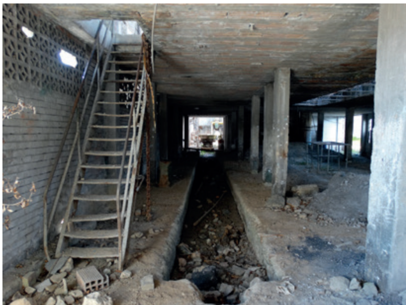
Figura 39. Ferroaleaciones – Ruina, escalera y foso. Fotografía: Autor, 2016
