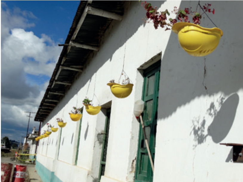
Figura 20. Estación del ferrocarril – Aprovechamiento de los cascos en desuso. Fotografía: autor, 2016
