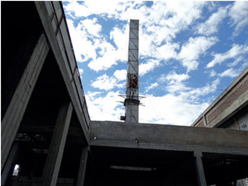
Figura 34. Ferroaleaciones – Chimenea metálica. Fotografía: Autor, 2016
