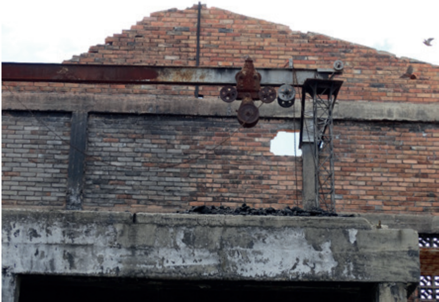
Figura 37. Ferroaleaciones – Ruina y puente-grúa. Fotografía: Autor, 2016
