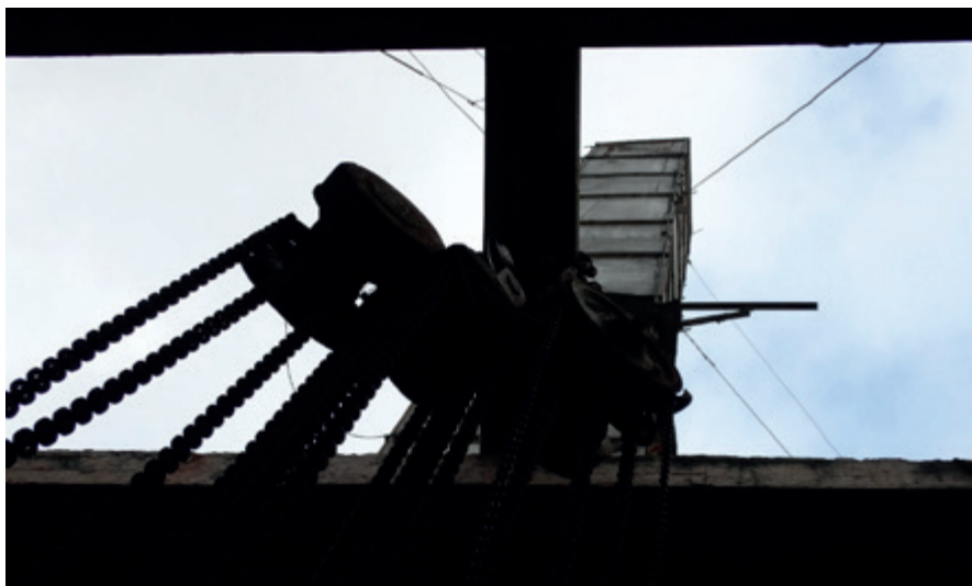
Figura 36. Ferroaleaciones – Chimenea y cadena transportadora - detalle. Fotografía: Autor, 2016
