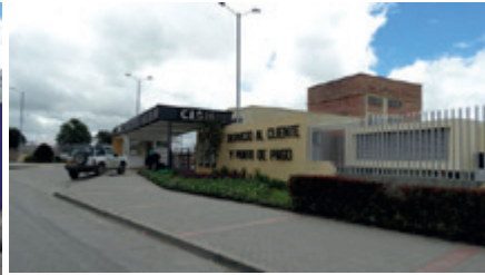
Figura 19. Centro de Servicios EBSA. Fotografía: Autor.
