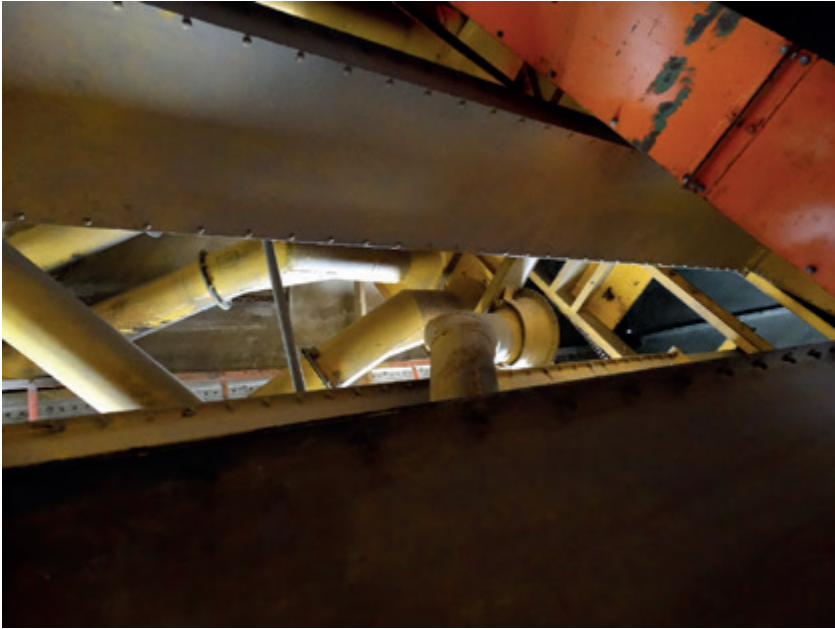
Figura 33. Silos del Idema – Estructura distribuidora de granos - detalle. Fotografía: Autor, 2016
